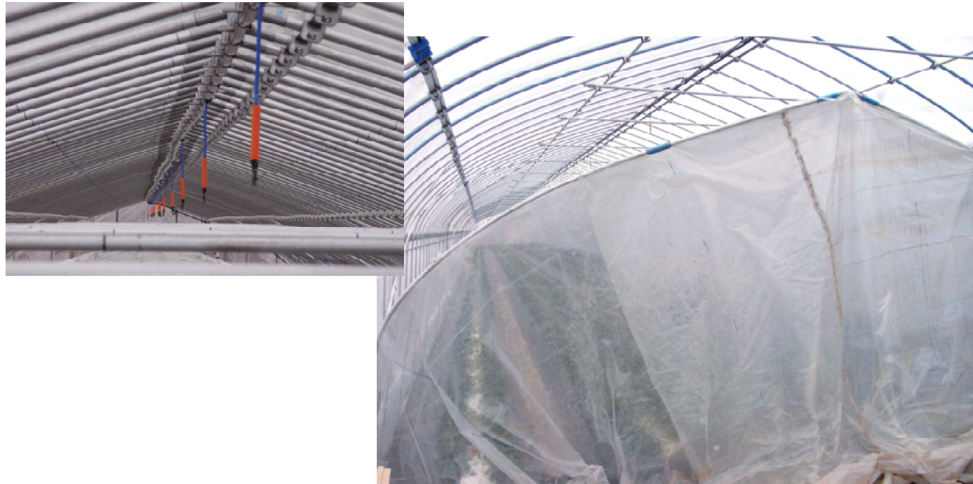
図08 ハングースプレーセットをハウスの内張り上部に4m間隔で取付けた配管例
