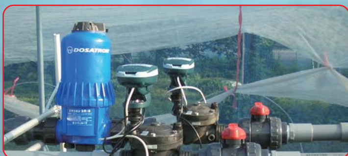
スプリンクラーシンカー設置例 (AC-6S)
