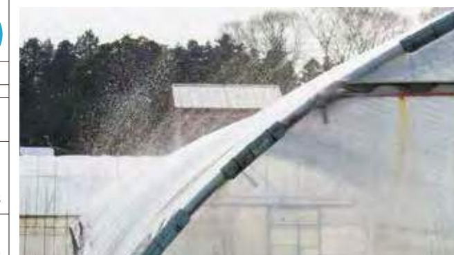
▲ MPローターによる屋根散水
