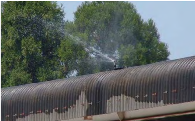
◀ スプリンクラーによる屋根散水
