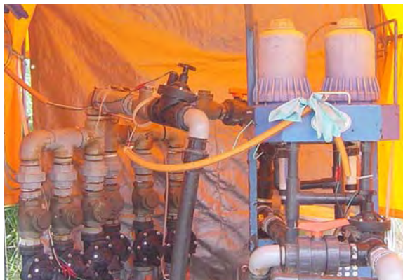
▲▶ドリップかん水と、比例式液肥混入器ドサトロンを使用した養液栽培は少ない肥料で高品質を可能にするシステムです。
