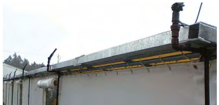
◀ MPローターによる屋根散水
