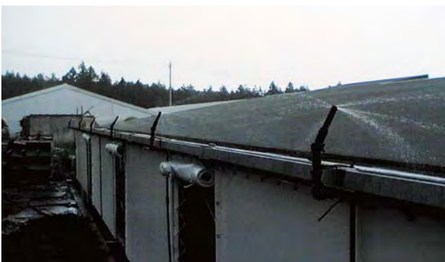
◀ MPローターによる屋根散水
